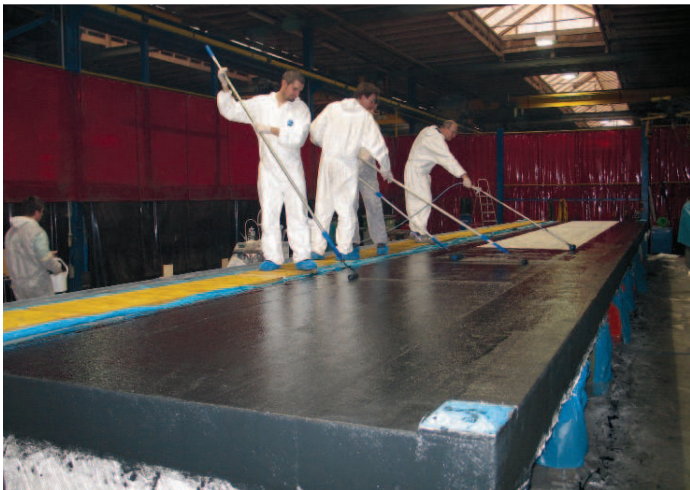
Die Unterseite der 18 Meter langen Fahrbahnplatte wird laminiert.
