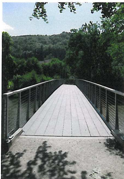
Sorgfältig längs verlegte Belagsprofile.
