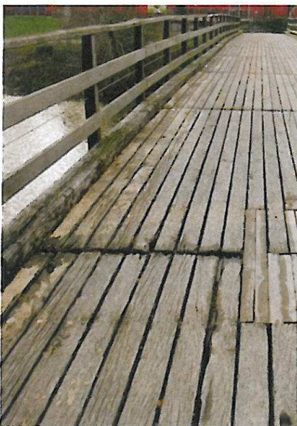
Brückenbelag aus Holz vor Instandsetzung.
